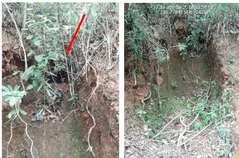
Figura 6-18 – Erosão linear em Macacos com destaque ao ponto de escoamento pluvial – EROF01/ADEF01
