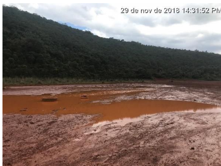
Figura 6-22 – Área degradada denominada Lagoa Seca – EROF08/ADEF09
