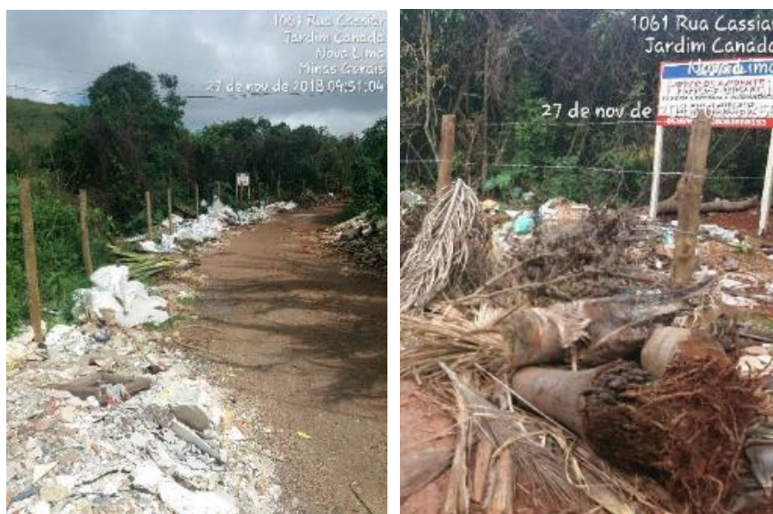
Figura 6-23 – Área degradada no Bairro Jardim Canadá – ADEF12
