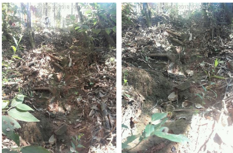
Figura 6-35 – Erosão linear no condomínio Pasárgada – EROT04/ADET04
