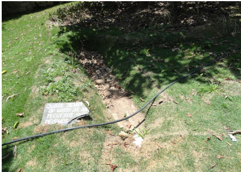
Figura 33 - Plantio de grama e implantação de caixa de captação de enxurrada em torno de nascente na bacia do ribeirão do Onça. FONTE: Acervo CBH Rio das Velhas, 2016.
