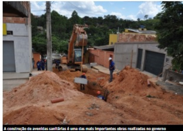
A construção de avenidas sanitárias é uma das mais importantes obras realizadas no governo
