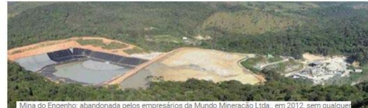
Mina do Engenho: abandonada pelos empresários da Mundo Mineração Ltda., em 2012, sem qualquer cautela.
