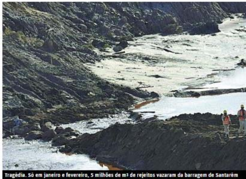
Tragédia. Só em janeiro e fevereiro, 5 milhões de m 3 de rejeitos vazaram da barragem de Santarém
