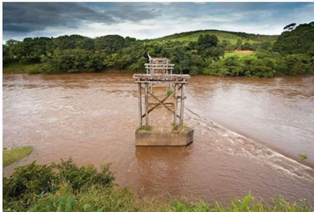
Antiga ponte sobre o Rio Paraúna em Presidente Juscelino - UTE Rio Paraúna
