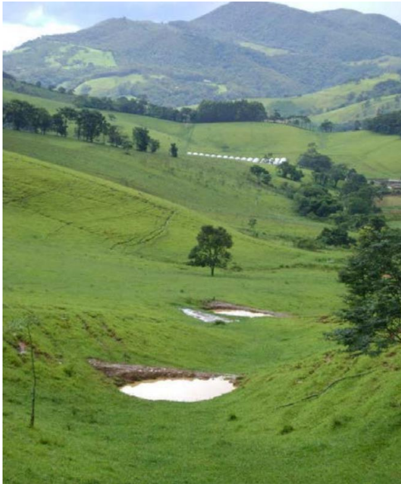
Figura 6 - Barraginhas construídas em áreas de recarga de nascentes.
