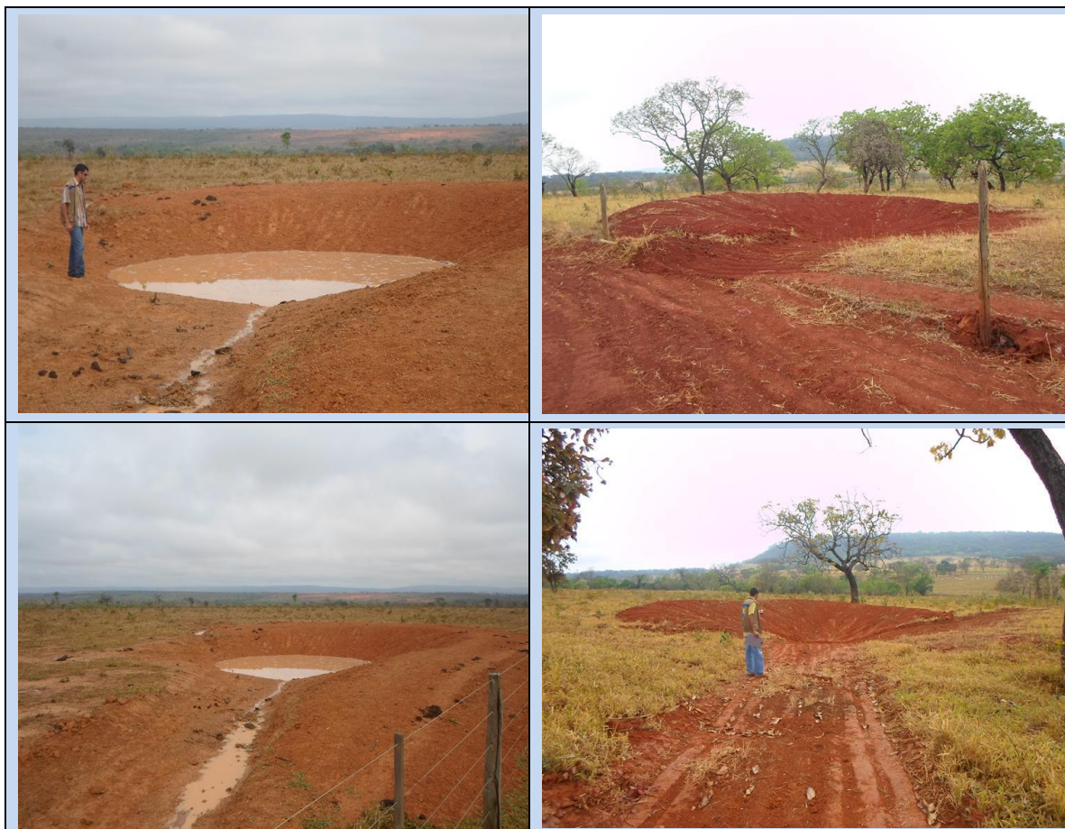
Figura 7 - Barraginhas para coleta de enxurrada gerada em estrada rural.
