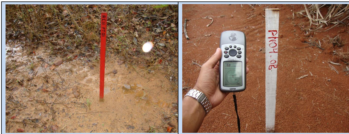
Figura 5 - Exemplos de estaqueamentos provenientes de locação topográfica de projetos hidroambientais.
