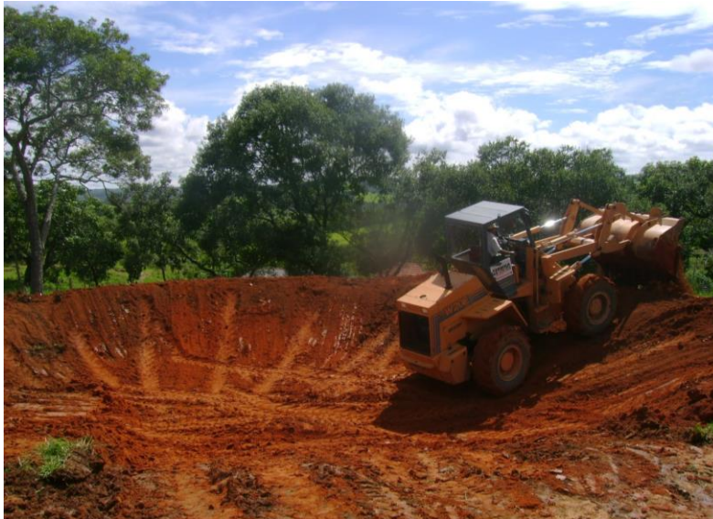
Figura 12 - Pá-carregadeira durante a construção de uma barraginha.
