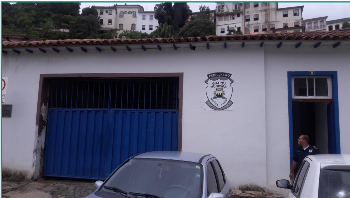
Figura 95 – Sede da Guarda Municipal de Ouro Preto. Fonte: Myr Projetos, 2016.
