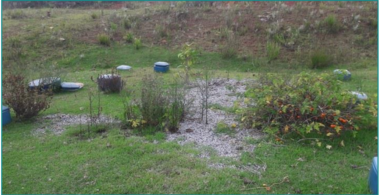
Figura 47 - Estação de tratamento anaeróbico. Fonte: Myr Projetos, 2016.
