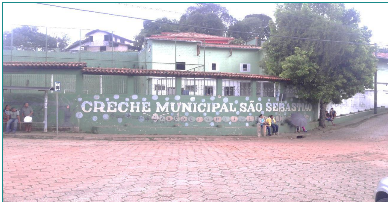
Figura 71 - Creche Municipal no Morro de São Sebastião. Fonte: Myr Projetos, 2016.
