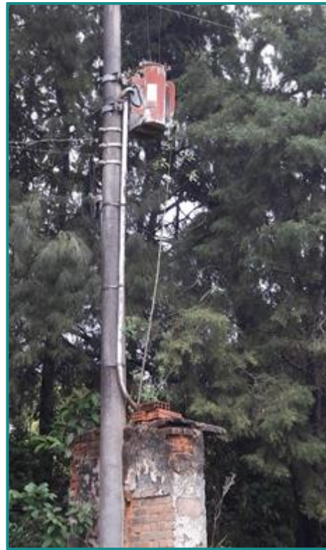
Figura 55 - Estrutura e transformador de energia elétrica. Propriedade Jeri. Fonte: Myr Projetos, 2016.
