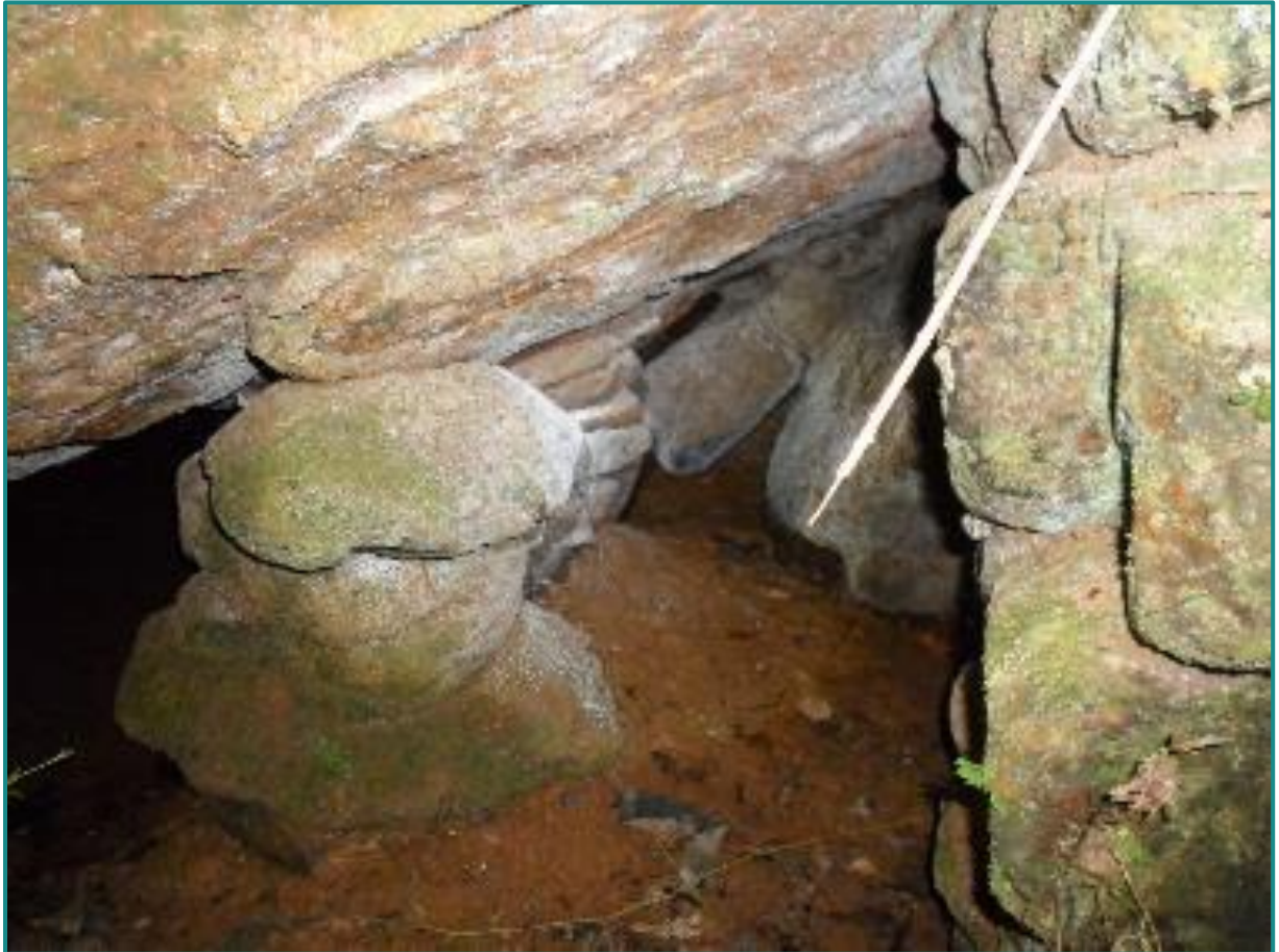
Figura 192 - Entrada de mina. Fonte: Myr Projetos, 2016.
