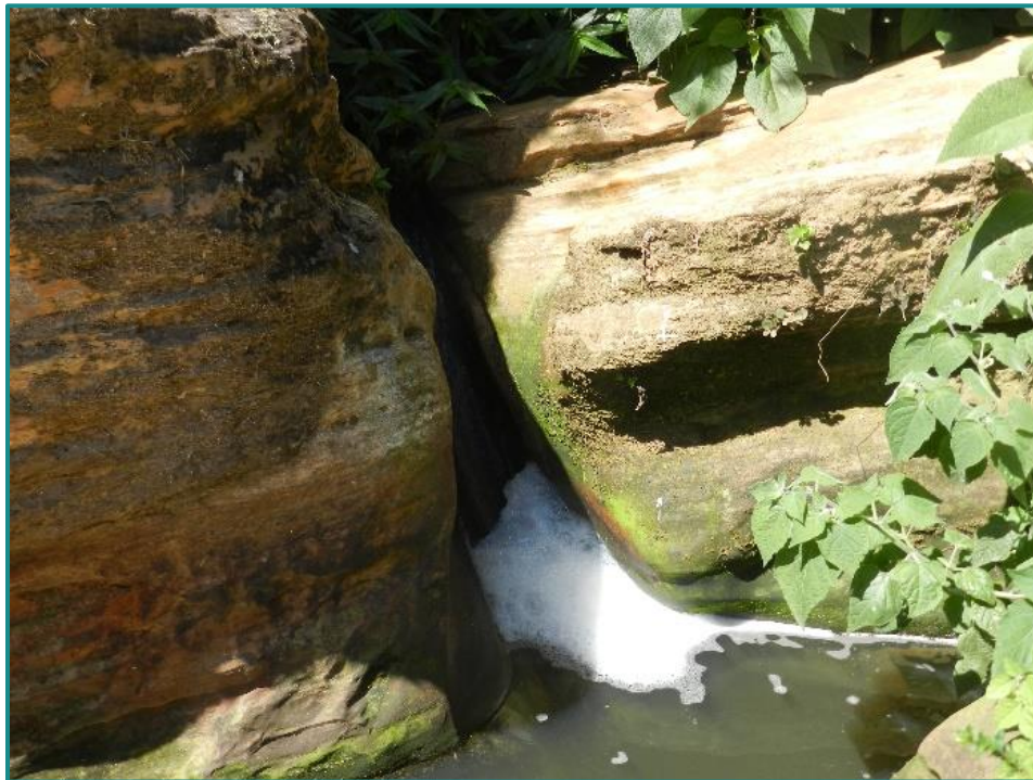
Figura 283 - Ponto de contaminação por esgoto proveniente da tubulação registrada na figura ao lado. Fonte: Myr Projetos, 2016.
