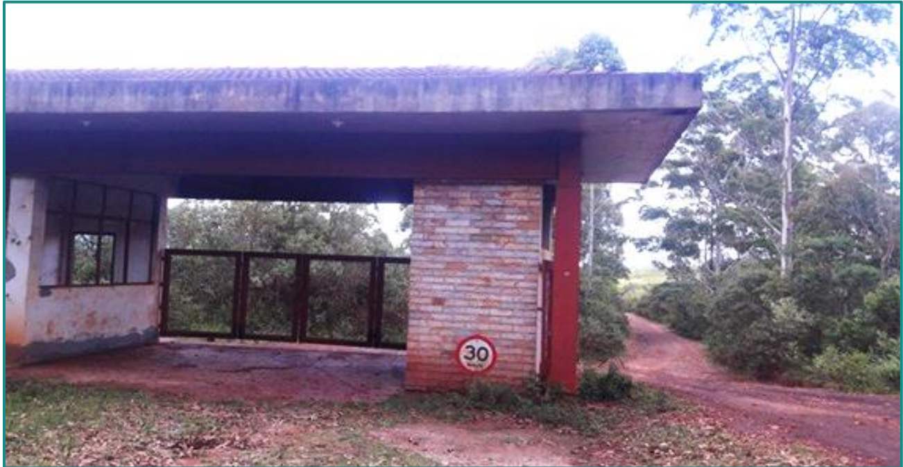
Figura 15 - Guarita de controle de acesso ao Parque. Fonte: Myr Projetos, 2016.
