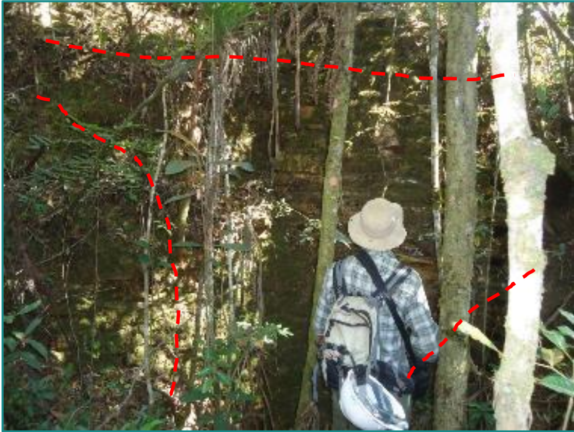
Figura 199 - Muro em pedra e junta seca, aparentemente um barramento para acúmulo de água. Fonte: Myr Projetos, 2016.
