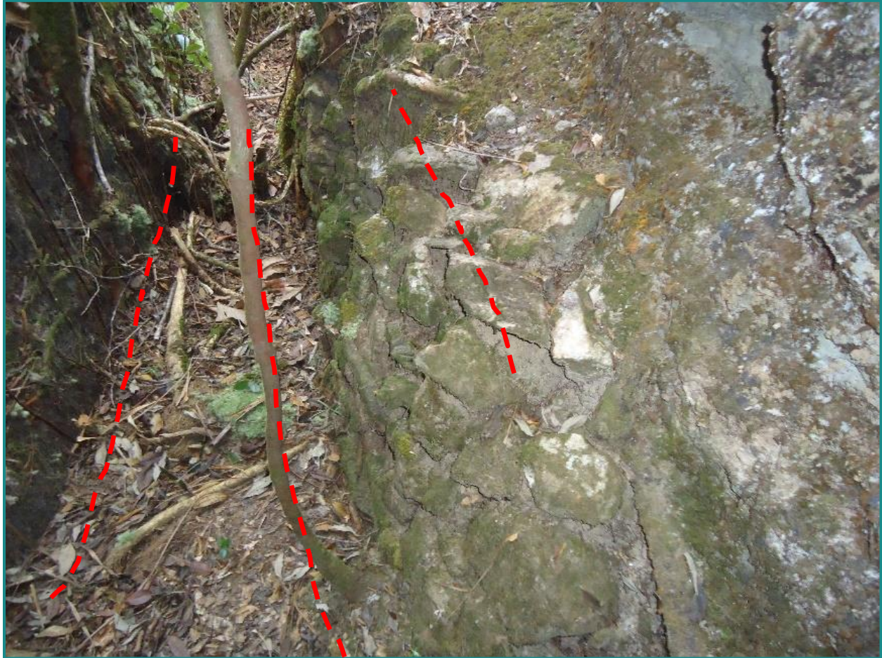
Figura 181 - Aqueduto. Fonte: Myr Projetos, 2016.
