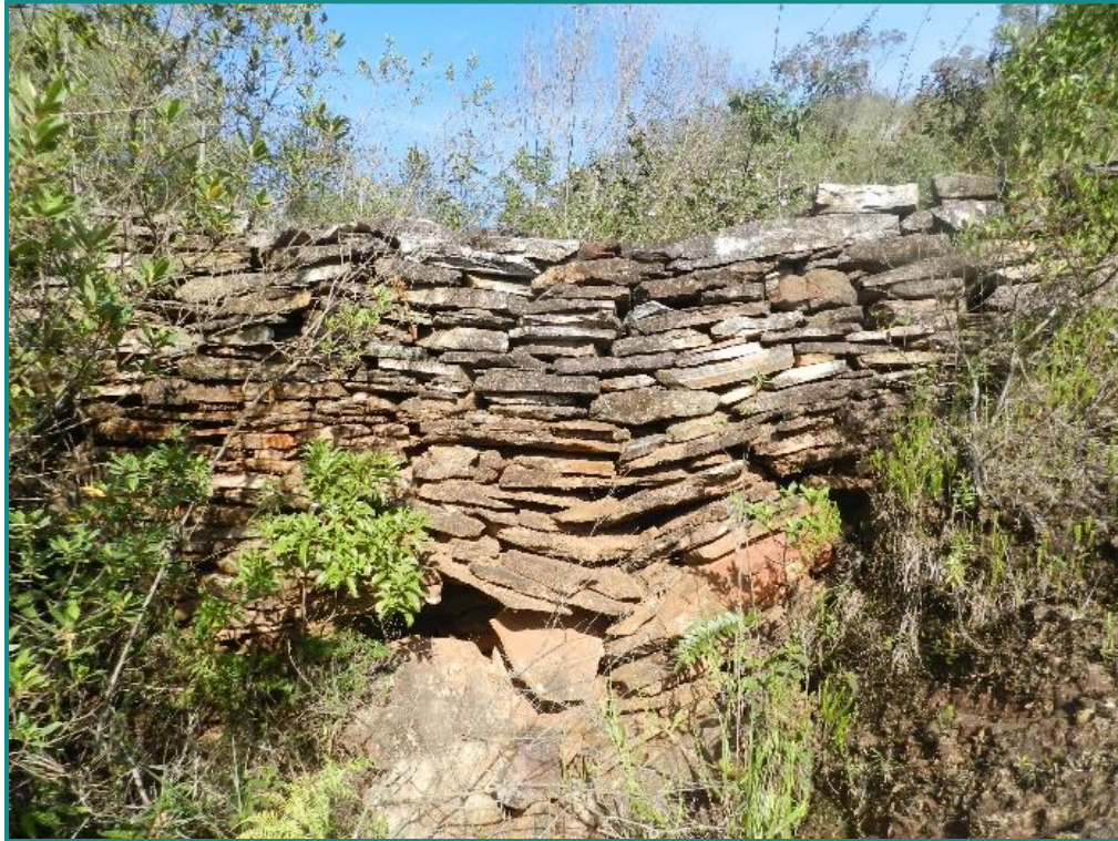
Figura 275 - Dique de gabiões construídos para barrar sedimentos na região da micro bacia das Camarinhas. Fonte: Myr Projetos, 2016.
