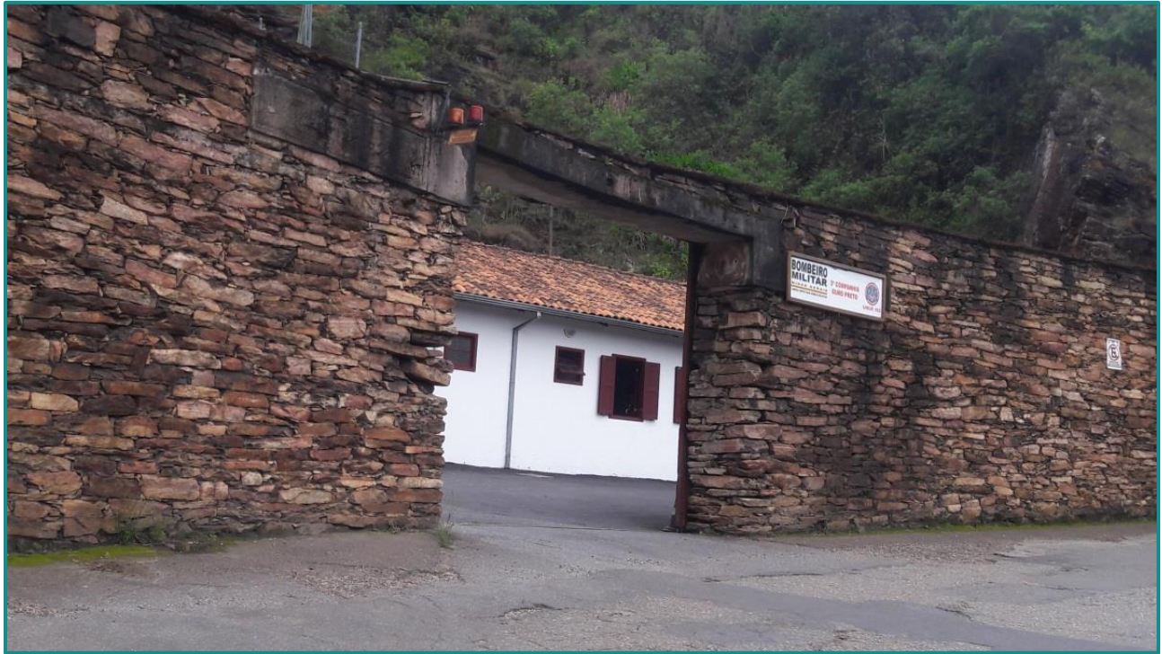
Figura 97 – Sede em Ouro Preto do 1º Pelotão do Corpo de Bombeiros Militares de MG. Fonte: Myr Projetos, 2016.
