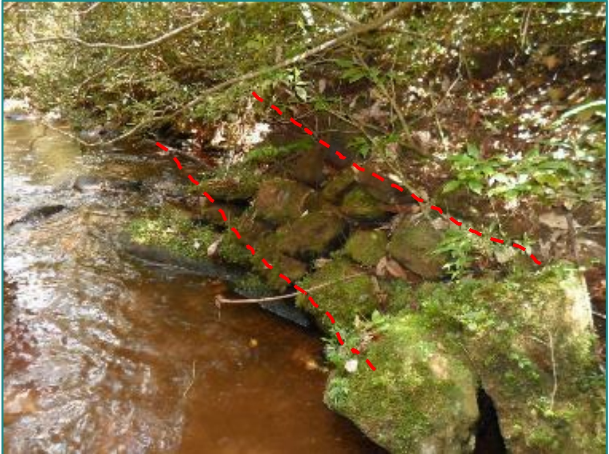
Figura 182 - Muro em pedra e junta seca, provável estrutura de mineração. Fonte: Myr Projetos, 2016.
