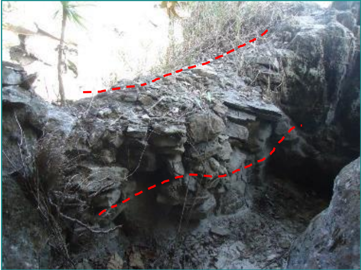
Figura 203 - Muro na entrada de um abrigo, executado em pedras e junta seca. Fonte: Myr Projetos, 2016.
