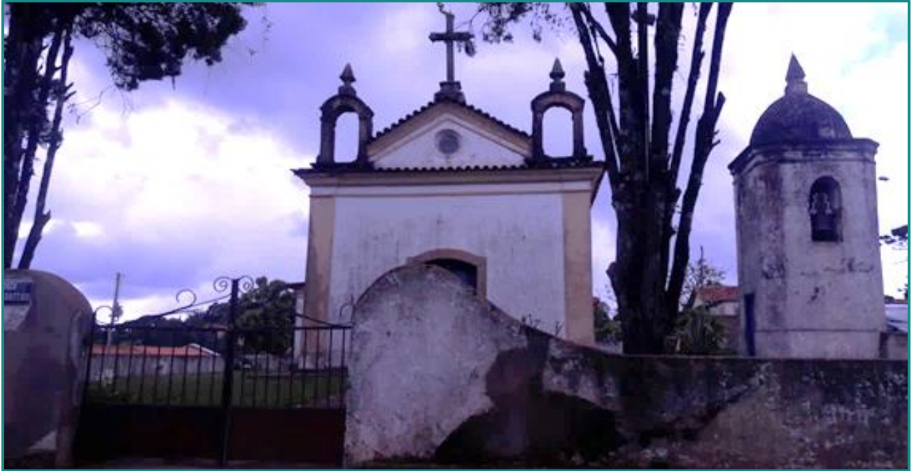
Figura 129 - Igreja de São Sebastião. Fonte: Myr Projetos, 2016.
