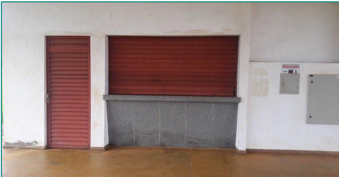
Figura 31 - Estrutura destinada à instalação de Cantina. Fonte: Myr Projetos, 2016.
