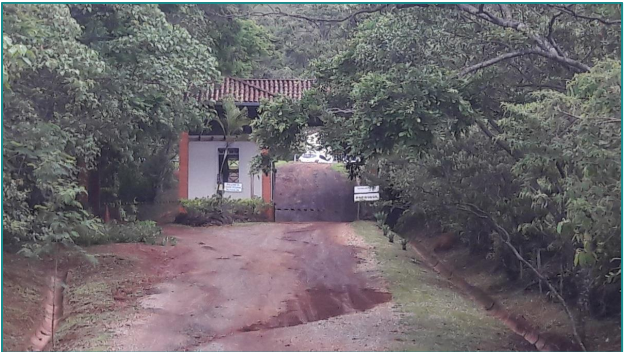
Figura 99 – Estrutura de controle de acesso ao Parque Estadual do Itacolomi. Fonte: Myr Projetos, 2016.
