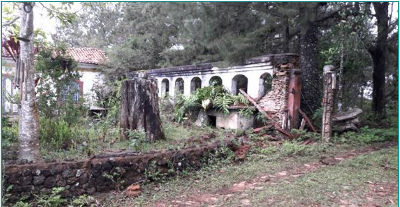
Figura 51 - Casario e ruínas. Propriedade Jeri. Fonte: Myr Projetos, 2016.
