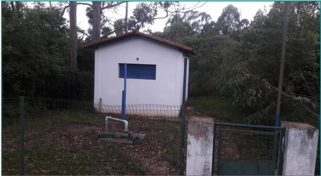
Figura 104 - Estação de elevação de esgotos. Fonte: Myr Projetos, 2016.
