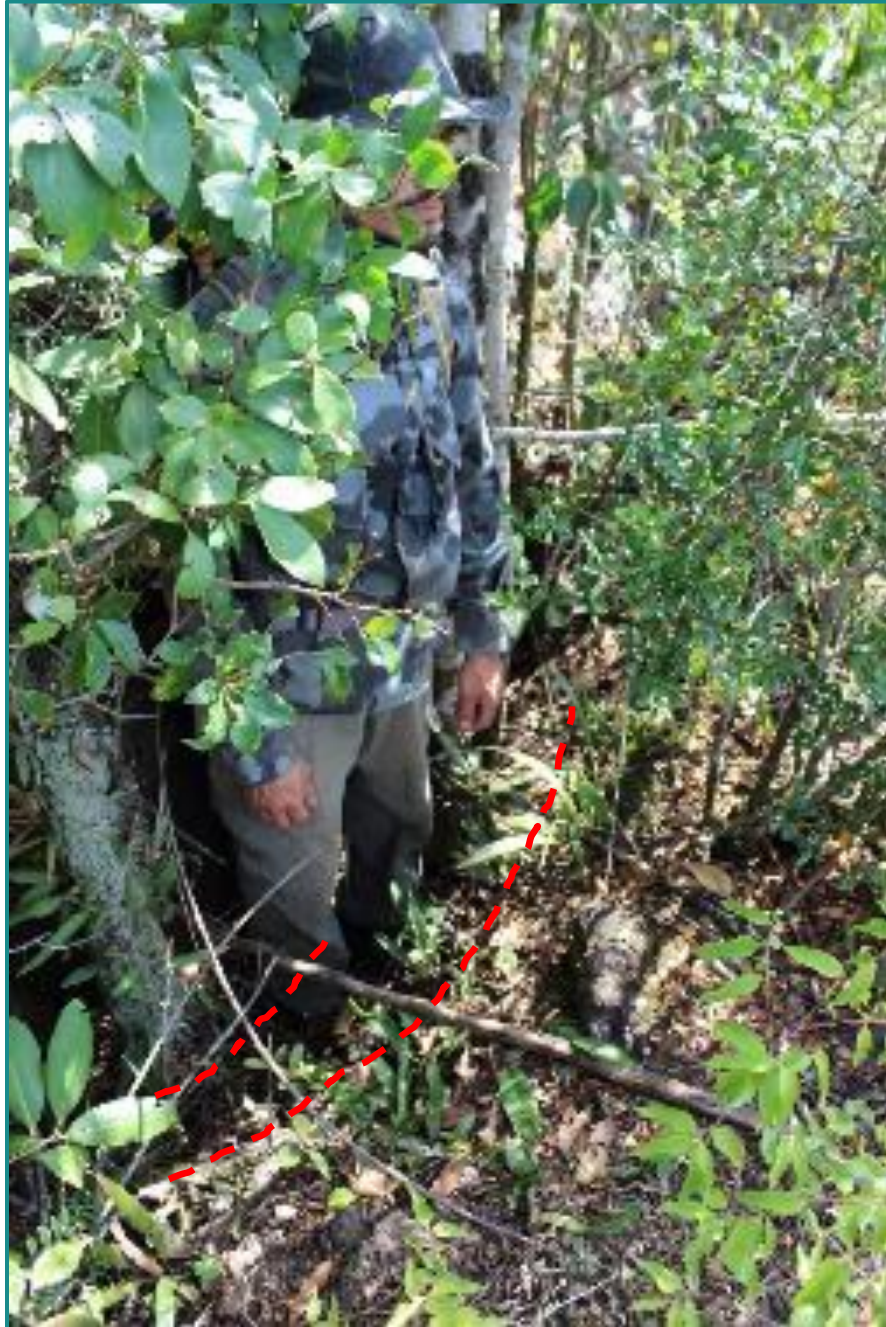
Figura 198 - Aqueduto. Fonte: Myr Projetos, 2016.
