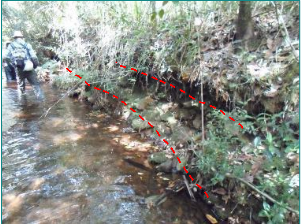
Figura 187 - Muro em pedra e junta seca, provável estrutura de mineração. Fonte: Myr Projetos, 2016.
