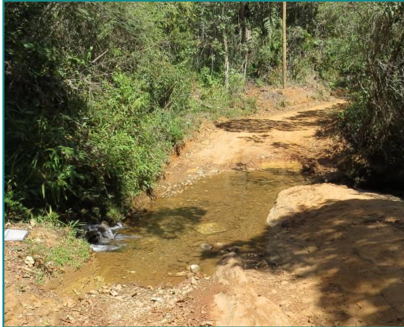
Figura 220 - Vista do local de amostragem com destaque para a passagem molhada. Fonte: Myr Projetos, 2016.
