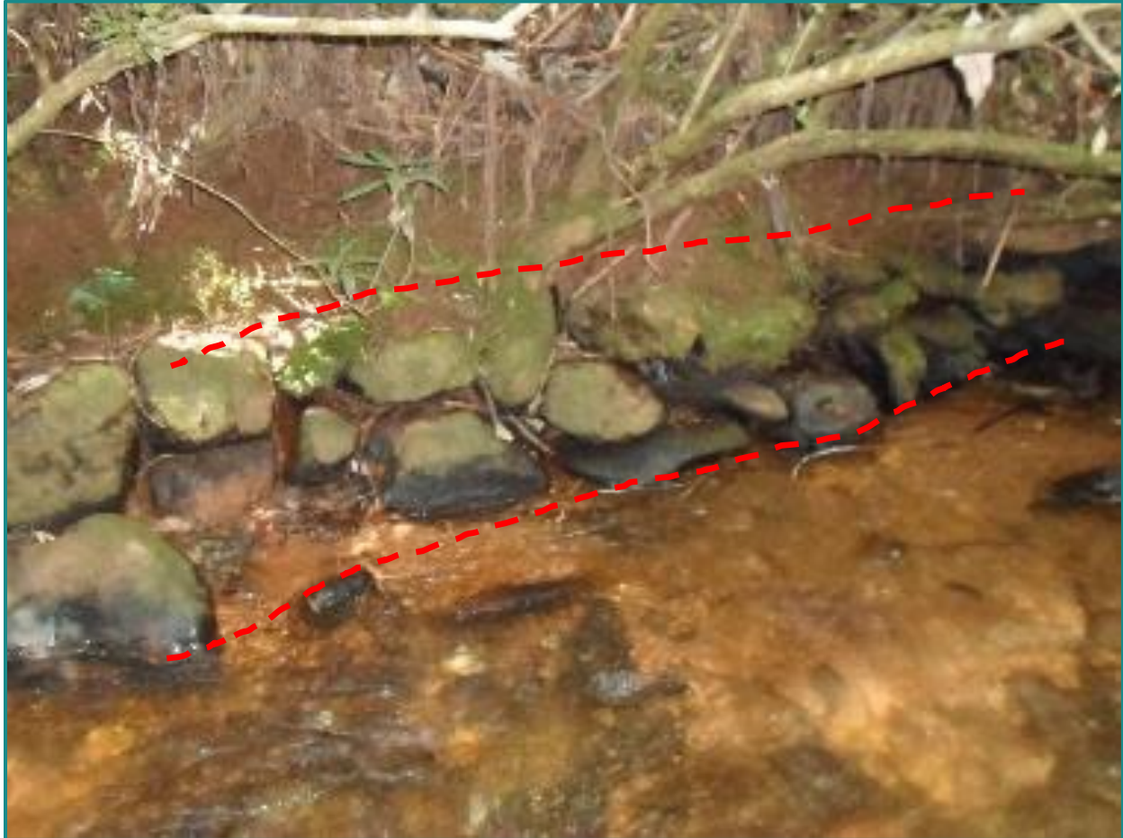
Figura 184 - Muro em pedra e junta seca, provável estrutura de mineração. Fonte: Myr Projetos, 2016.
