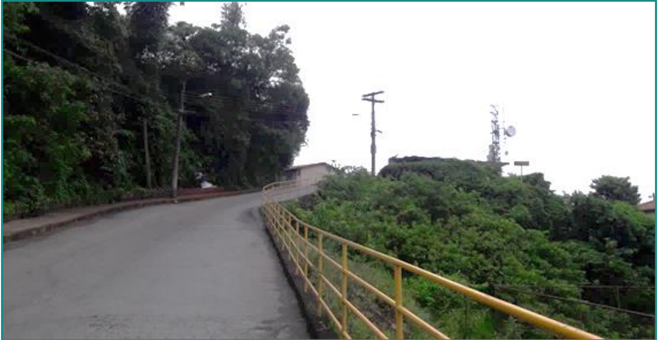
Figura 118 - Via asfaltada de acesso, com grande declividade. Fonte: Myr Projetos, 2016.
