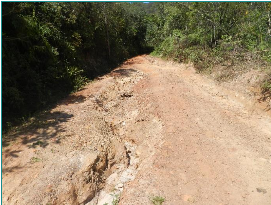
Figura 265 – Ocorrência de processos erosivos nos acessos ao PNMA. Fonte: Myr Projetos, 2016.
