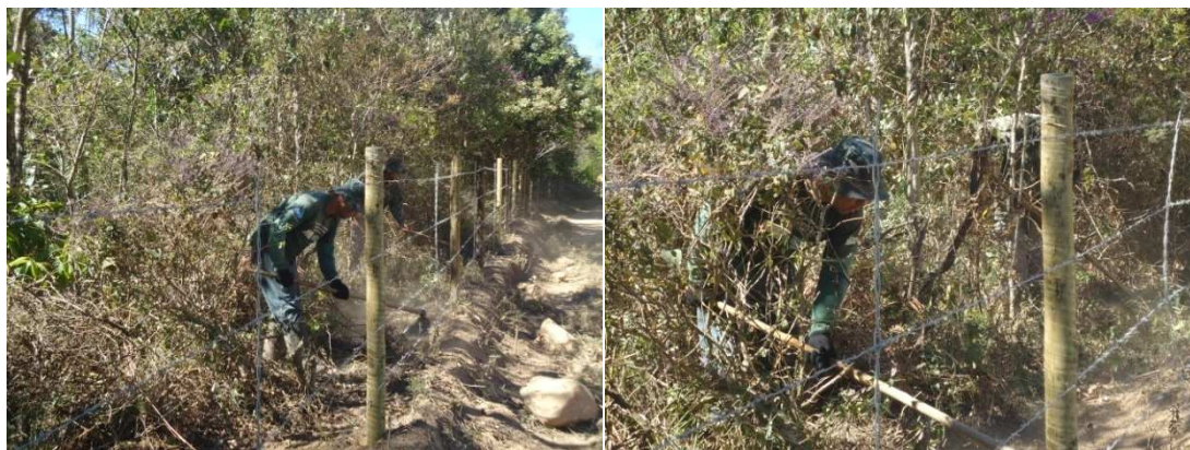
Figura 7: Construção de aceiros.
