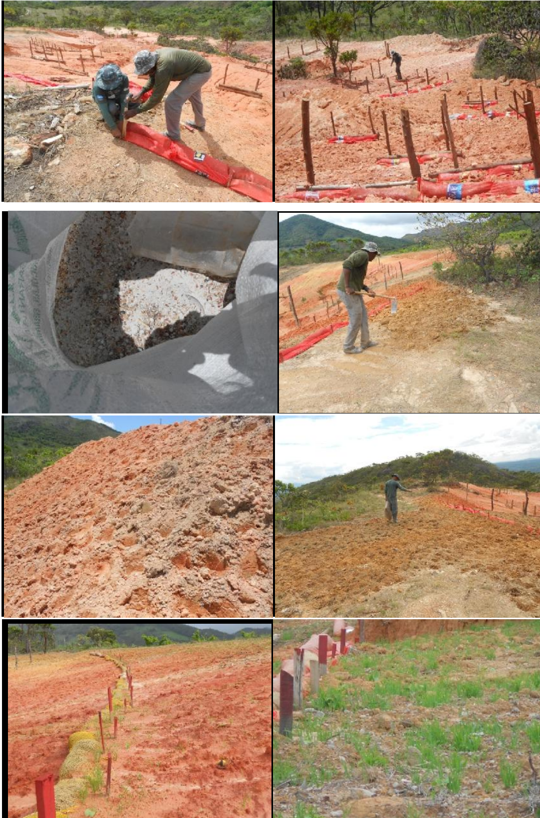
Figura 5: Estabilização e recuperação de voçorocas
