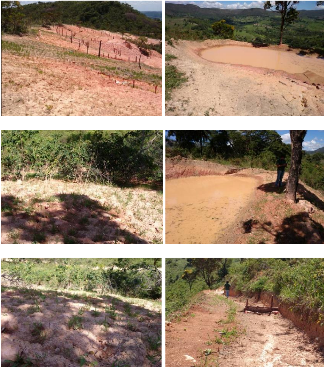
Figura 8: Estabilização e recuperação de voçorocas
