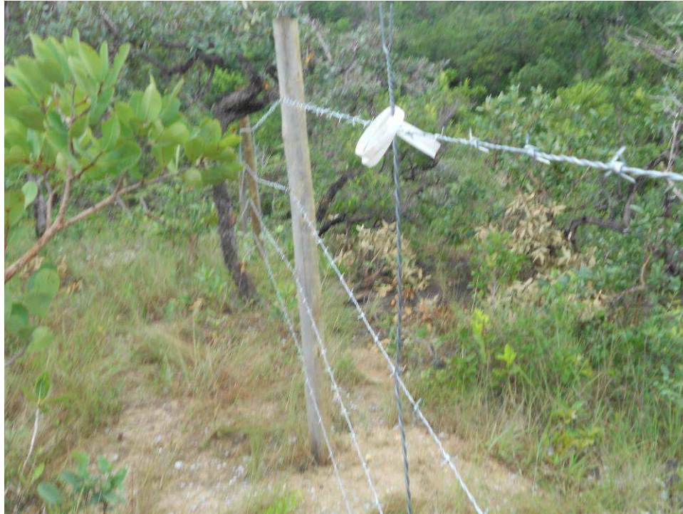
Figura 18: Construção de aceiro e cerca.
