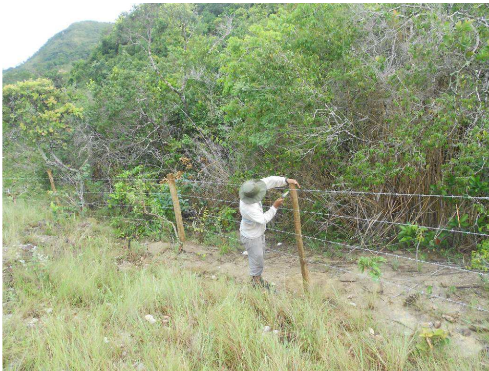
Figura 20: Construção de aceiro e cerca.
