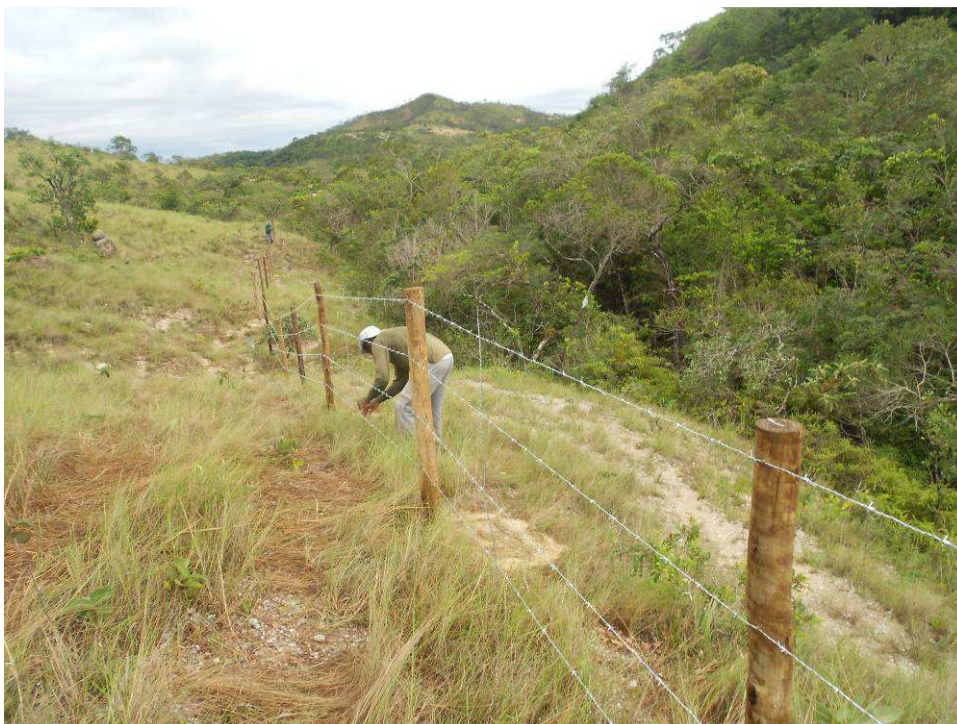
Figura 19: Construção de aceiro e cerca.
