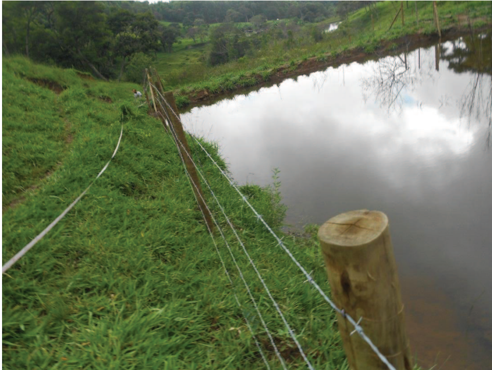
Figura 23: Construção de cerca na propriedade do Sr. Edmar.
