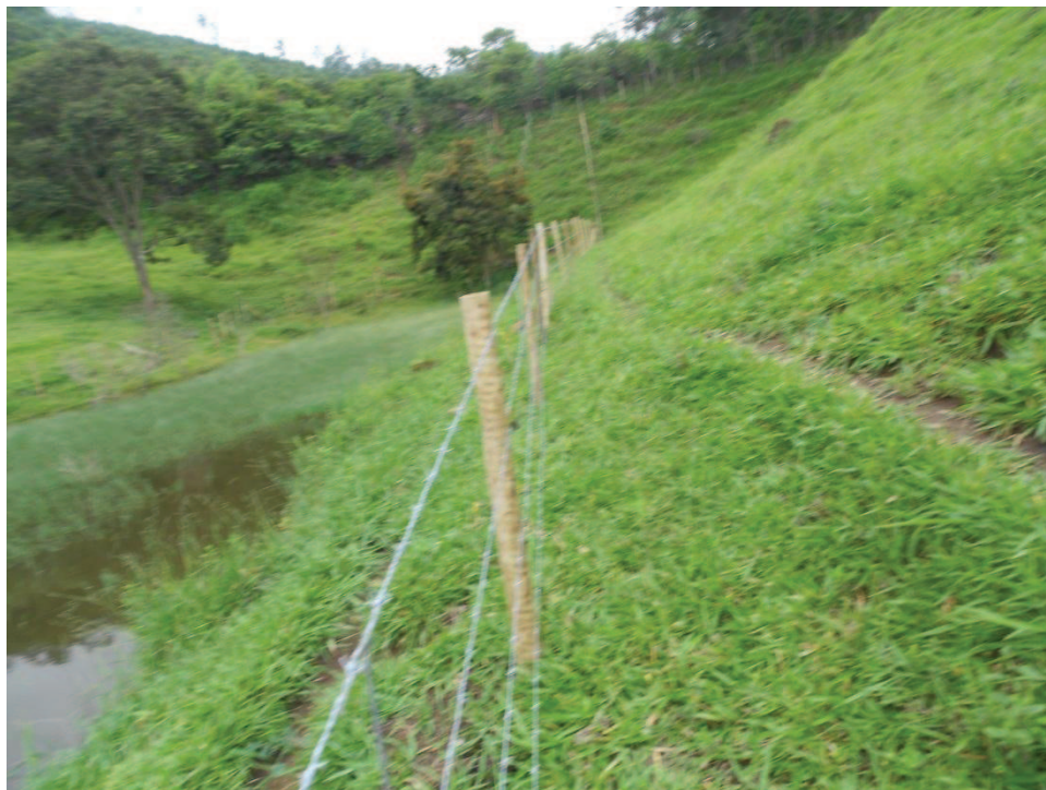
Figura 22: Construção de cerca na propriedade do Sr. Edmar.
