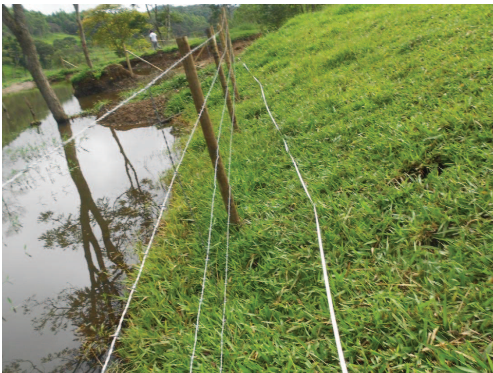
Figura 24: Construção de cerca na propriedade do Sr. Edmar.
