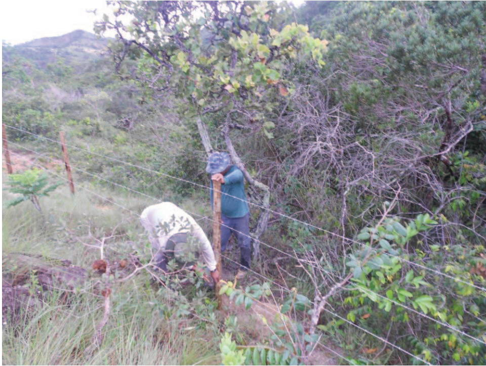
Figura 27: Construção de cerca na propriedade da Sra. Virginia
