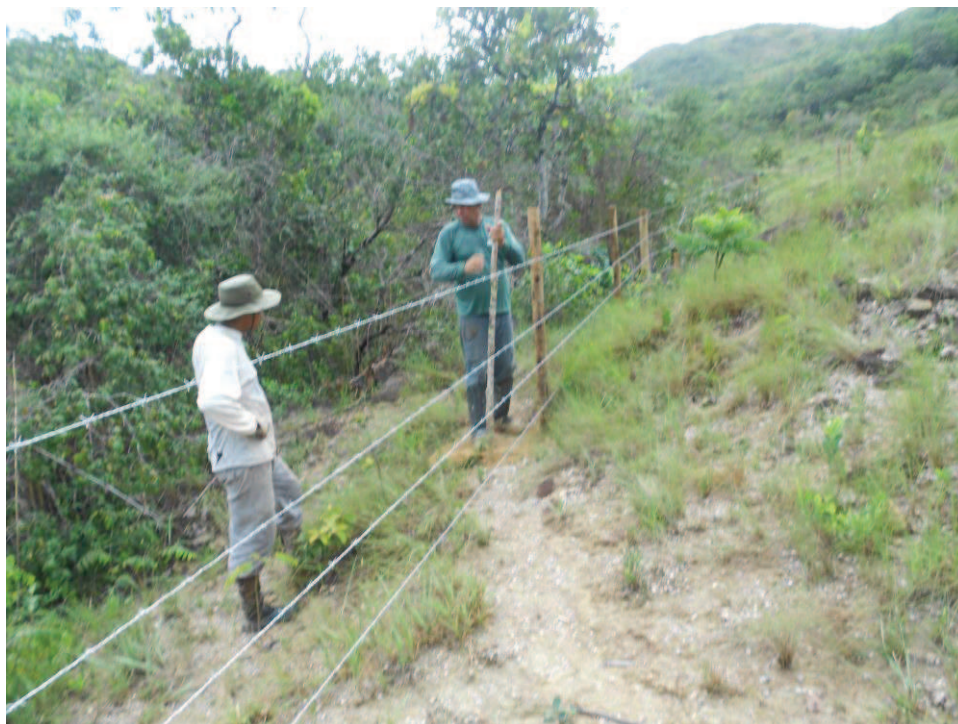
Figura 26: Construção de cerca na propriedade da Sra. Virginia Fonte: Arquivo fotográfico GOS Florestal.
