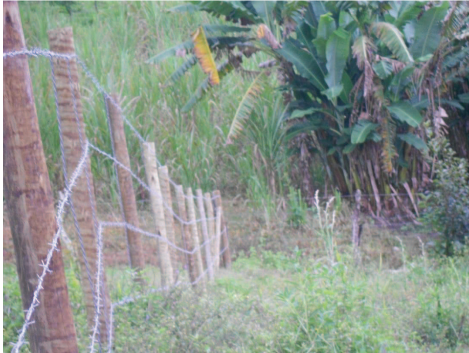
Figura 21: Construção de cerca na propriedade do Sr. Edmar.
