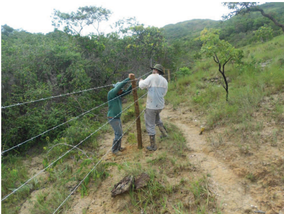
Figura 28: Construção de cerca na propriedade da Sra. Virginia
