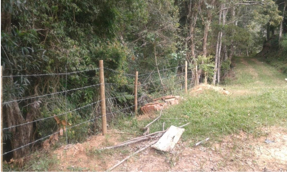
Figura 15: Construção de cerca na propriedade do Sr. Tatão. Fonte: Arquivo fotográfico GOS Florestal.
