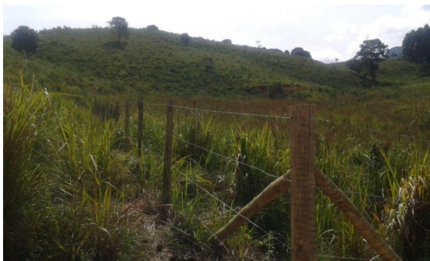
Figura 18: Construção de cerca na propriedade do Sr. Tãozinho. Fonte: Arquivo fotográfico GOS Florestal.
