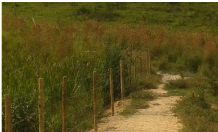
Figura 19: Construção de cerca na propriedade do Sr. Tãozinho. Fonte: Arquivo fotográfico GOS Florestal.
